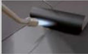
1- Mise en œuvre de l'étanchéité SOPREMA sous AT sur isolant de classe C ou supérieur.
