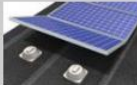
3- Pose des cache-plots sur les plots en extrémité d'une série de modules.
