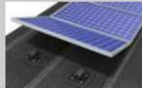
4- Pose des modules, des étriers et raccordement électrique à l'avancement.
